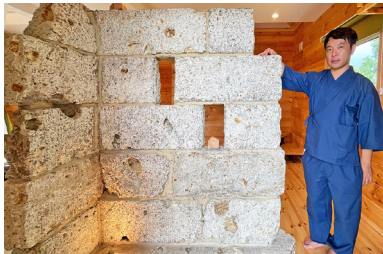
大谷石を使用した目隠し壁。
