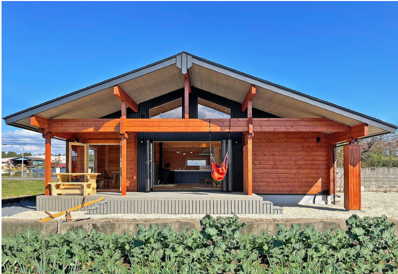
メンテナンス性を高めている平屋タイプとガルバリウムの妻壁
