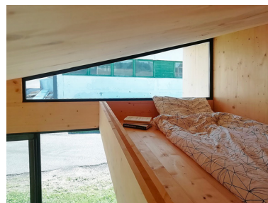
CLT構造で大開口の窓でも強度を確保
