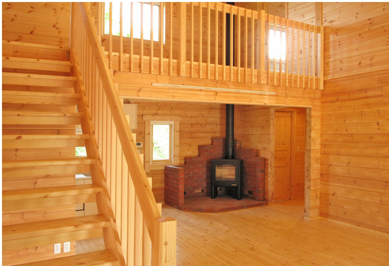
1階を効率よく温めるため、薪ストーブは吹き抜けに設置せず、ロフトの下にしました。
