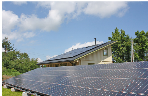
庭にも太陽光パネルを設置。売電により電気代はかからない。
