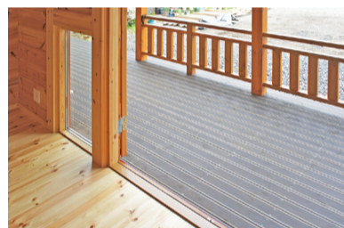
2メートルと広めのデッキ。
