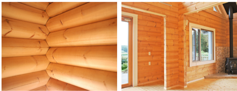
丸太や角ログをガッチリ組み合わせたログ壁はそう簡単には崩れることはない。
