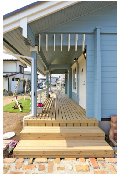
デッキには丸テーブルを置く予定
