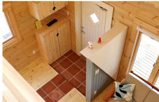
玄関脇の目隠し壁。土間は素焼きのテラコッタ
